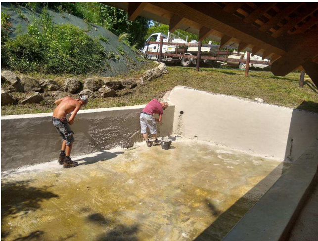
Les professionnels viennent enduire les murs réparés.
