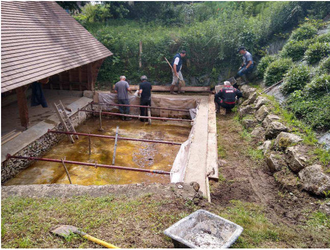
Préparation du chantier par la Municipalité et les Randonneurs
