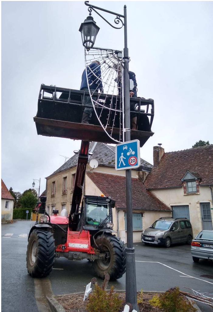
La Municipalité n'hésite pas à utiliser les grands moyens pour installer les luminaires de Noël.
